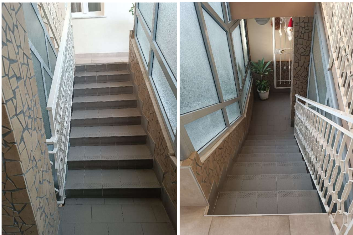
Foto 7 - Foto 8: Scala acceso al piano primo unità immobiliare dal cortile interno
