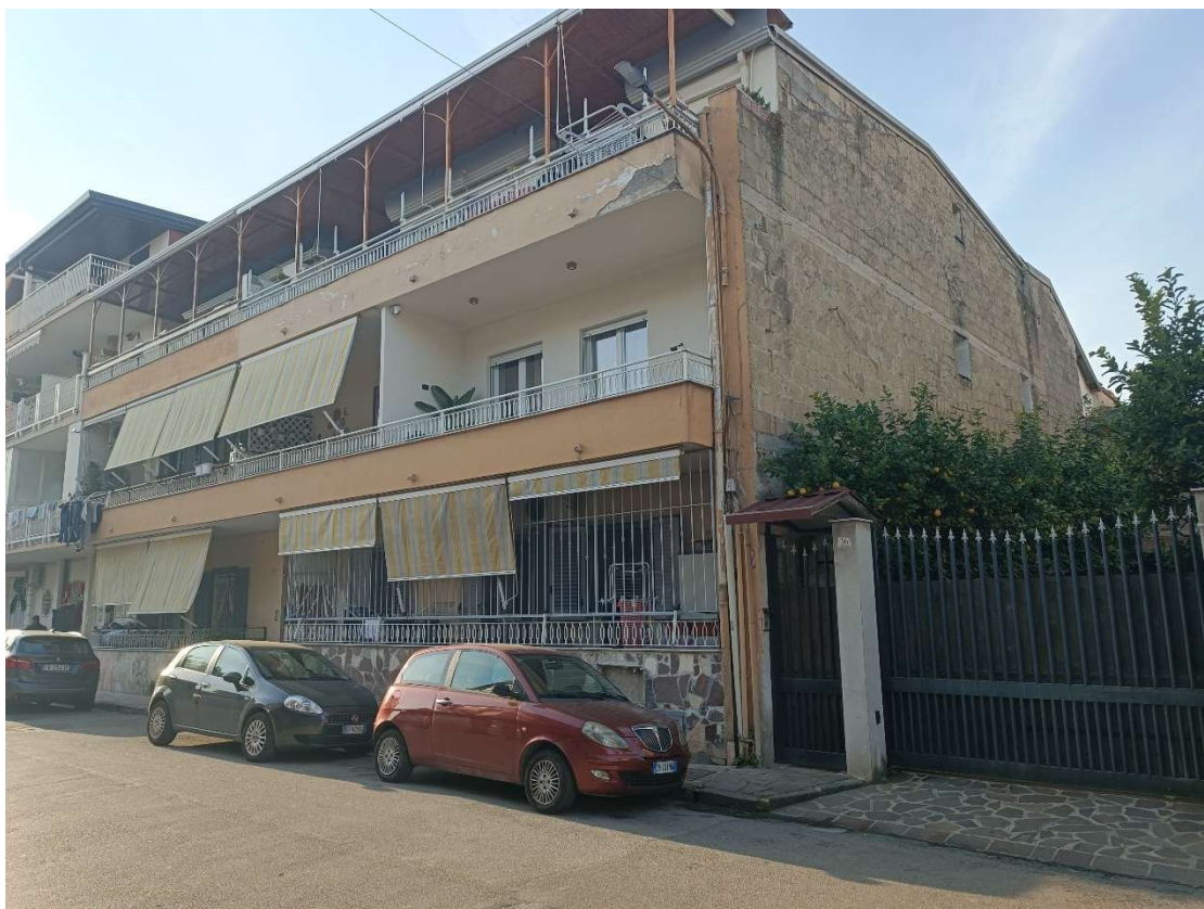
Foto 1: Esterno strada di accesso unità immobiliare – Via Marconi
