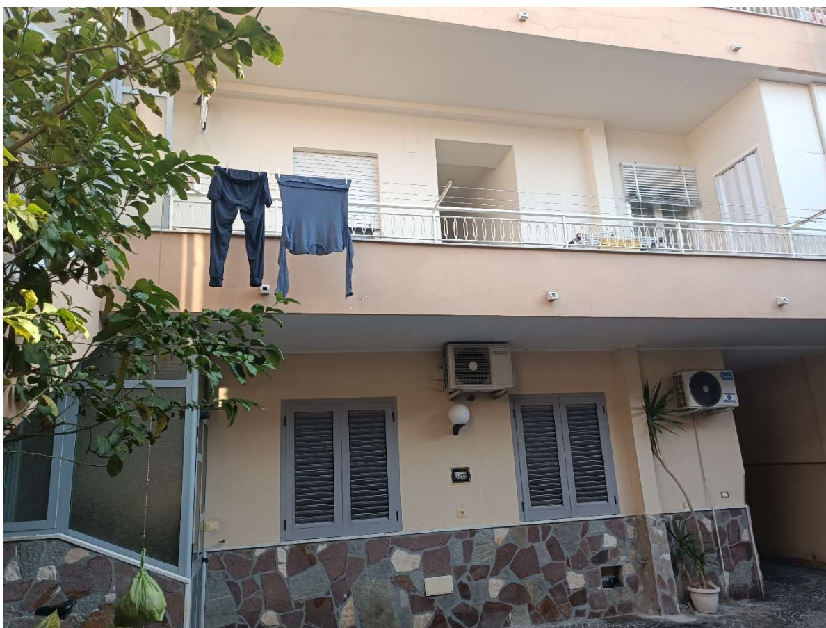
Foto 2. Prospetto interno cortile
